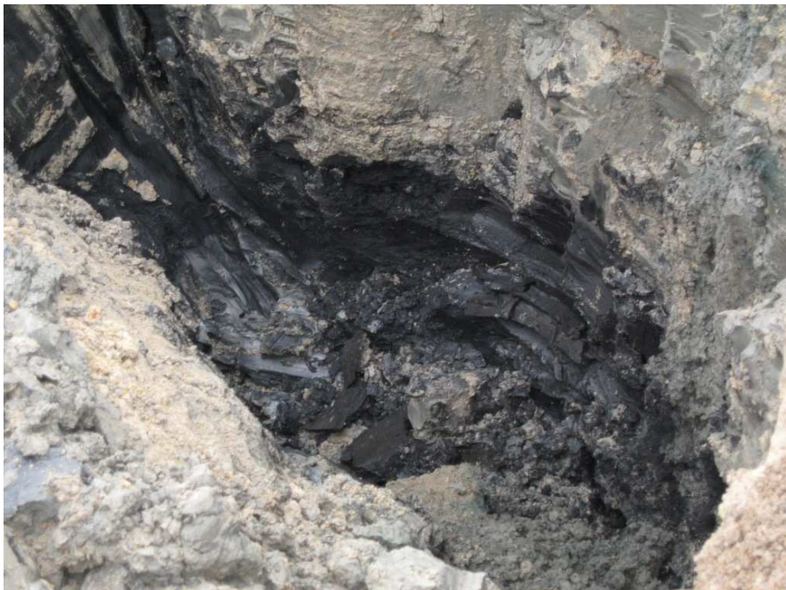
Figur 4-11. Pelare E9 framschaktad i sulfidjorden. Det är svårt att urskilja någon pelare från 3 m djup och nedåt.
