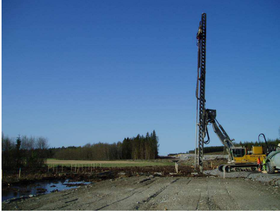
Figur 4-3. Installation av pelare med Hercules KC-maskin.
