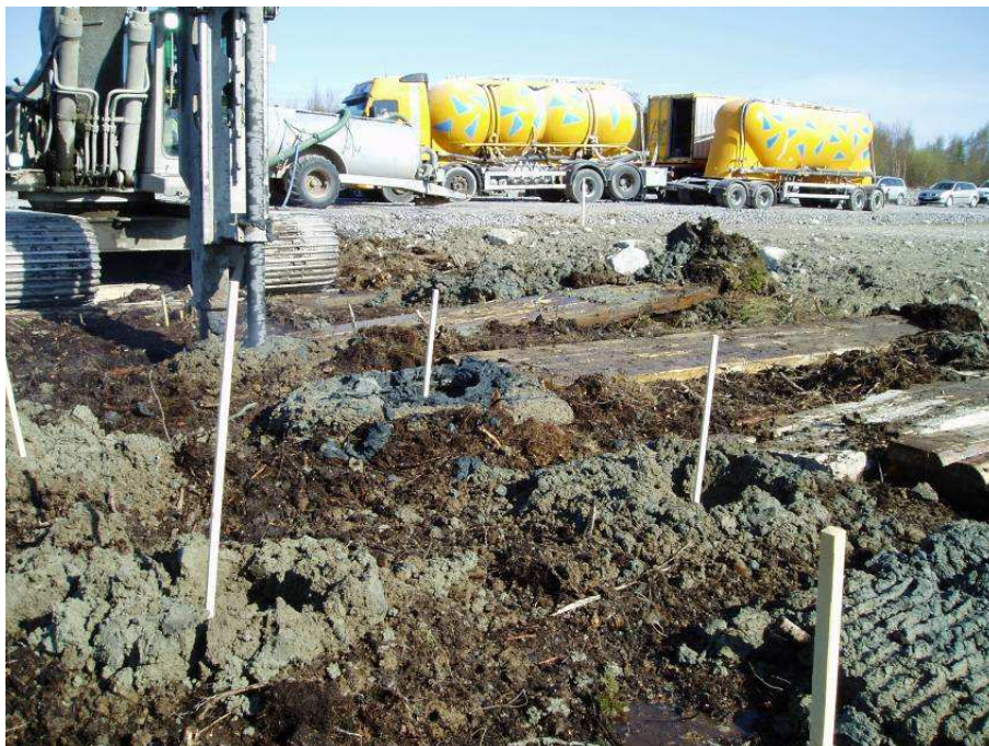
Figur 4-4. Installerade pelare.
